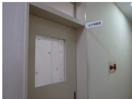
【角館消防署女性専用施設】
